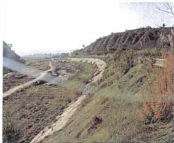
K4+200 处浆砌石护坡
