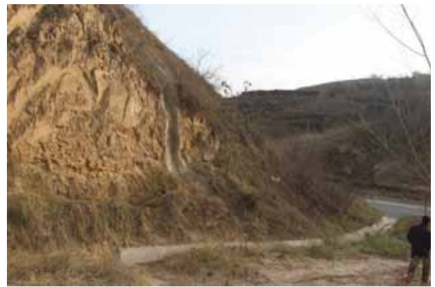
K10+000 挖方路基侧坡面简易急流槽
