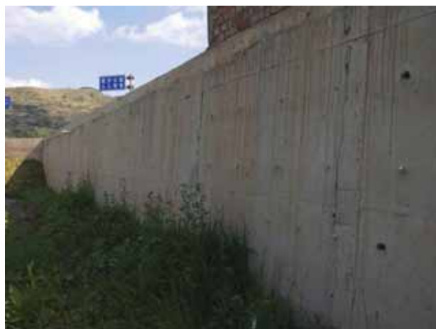
K28+750 南湖汽车站新修挡土墙
