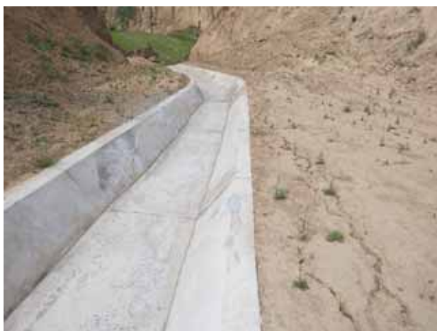
K37+300 排洪渠整治
