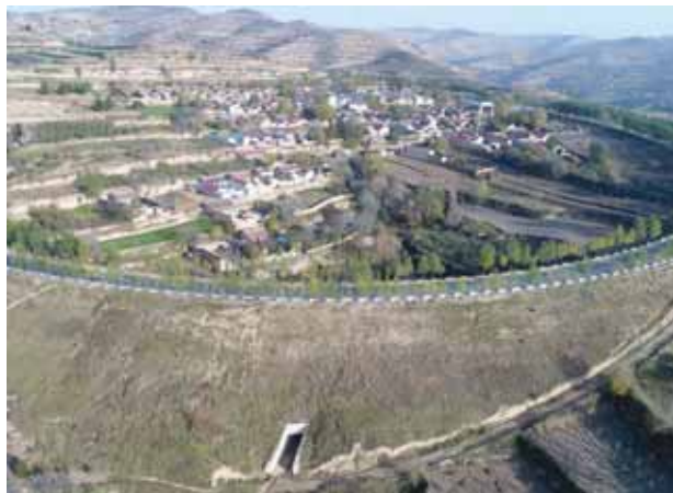
蛟龙掌控制点回填路段边坡绿化
