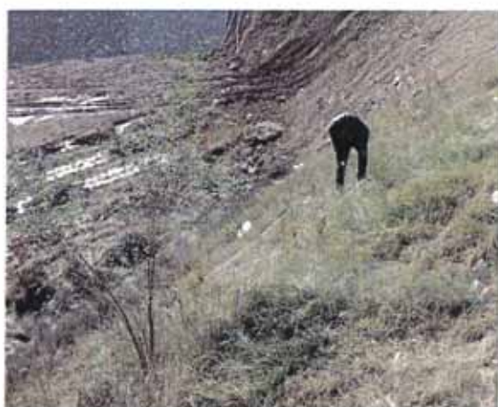
路基边坡监测点
