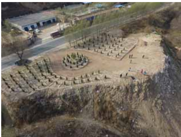
B6 弃渣场渣面整治、绿化
