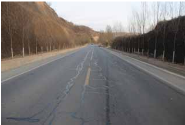
K24+600 公路两侧绿化及砼排水边沟
