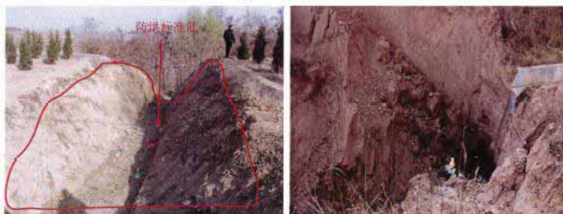
K37+300 左侧弃渣场排洪设施不完善
