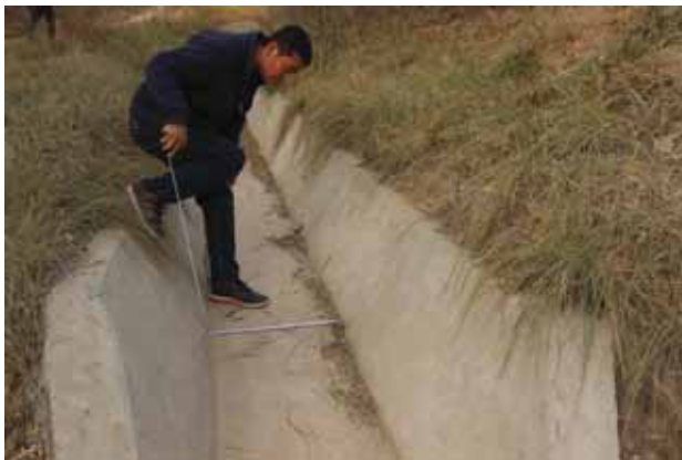
K10+000 路侧砼排水沟调查
