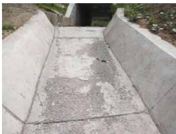
K37+300 排洪渠整治
