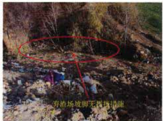
K37+300 左侧弃渣场无拦挡、边坡分级等措施
