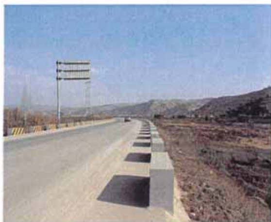
线路起点（威戎）
