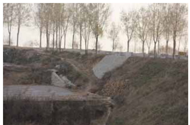
K13+300 填方路基边坡植物防护及浆砌石护坡
