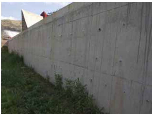
K28+750 南湖汽车站新修挡土墙
