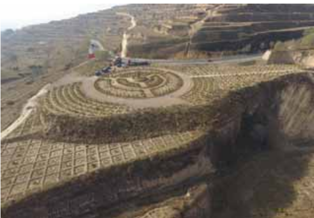
B8 弃渣场分级整治渣面绿化
