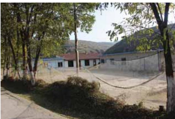
K6+300 二标施工营地
